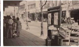
昭和36年の完成したばかりの西山商店街。アーケードはまだない(写真提供:名古屋市市政資料館)
