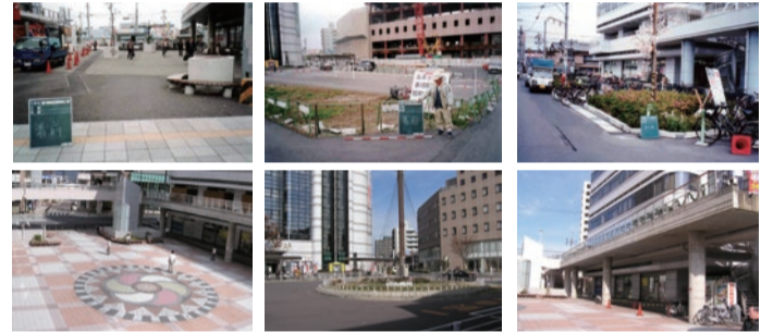
上:開発工事着手前と、下:工事完了後の様子。駅前公園、駅前広場、ペDESTリアンデッキなど総合的に再開発された。(写真提供:春日井市都市整備課)
